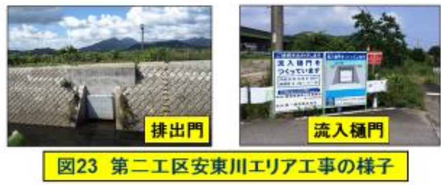
図23 第二工区安東川エリア工事の様子
